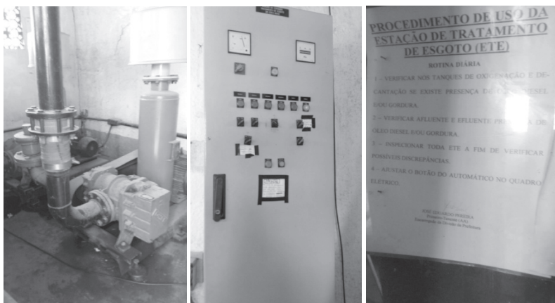
Figura 2: Ilha do CIAW. Estação de Tratamento de Esgoto. Fonte: arquivo da autora
