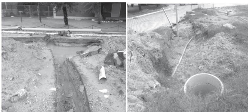
Figura 3: Obras de saneamento do Complexo da Avenida Brasil. Fonte: arquivo da autora.
